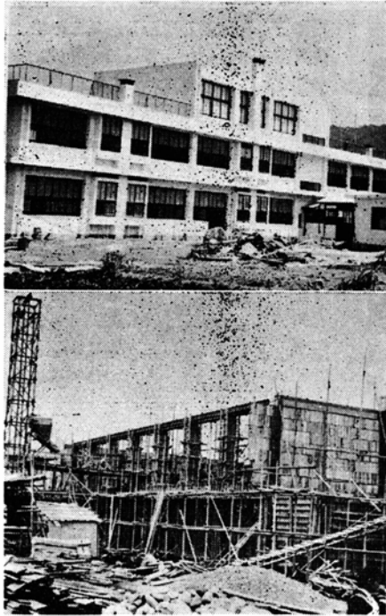
(写真上は 第3期工事の完成と 下は 第4期の工事現場)
