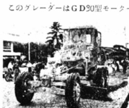
(写真は作業中のグレーダー)
