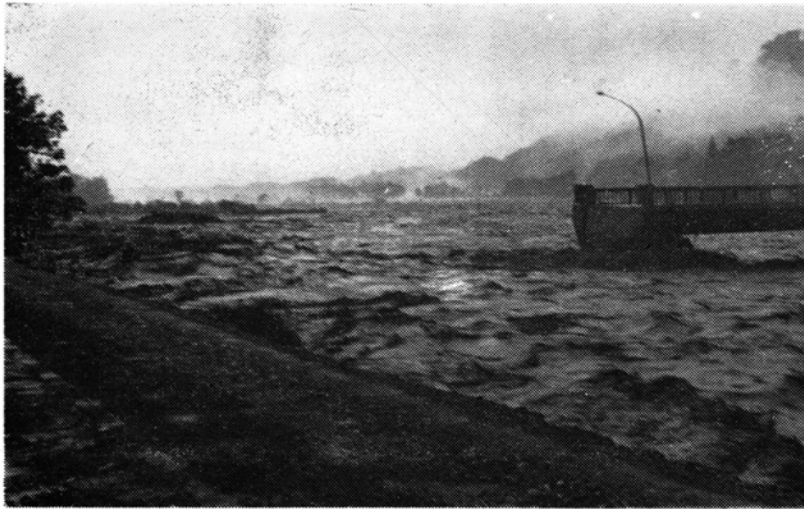
写真は佐開橋の一部を流失して荒れ狂う真名川
