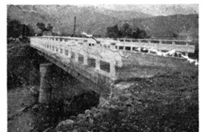
(完成した吉村橋)
