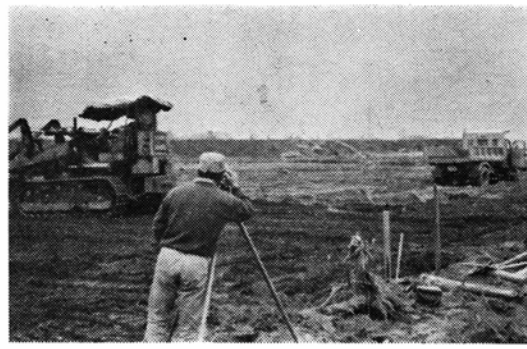
耕地災害復旧工事現場(堂本地係) 受益面積5ヘクタール
