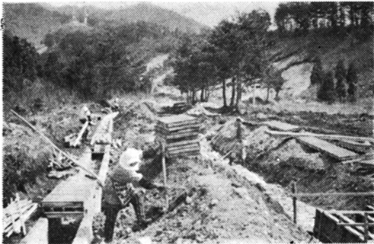
蕨生、荒島スキー場線の復旧工事(蕨生地係) 延長1,471m 総事業費1千600万円
