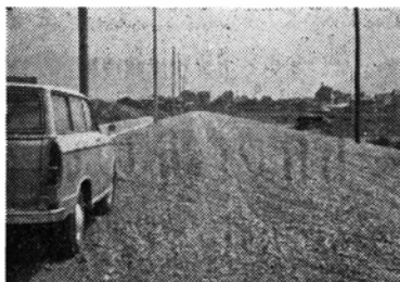
(完成した都市計画道路向島線)
