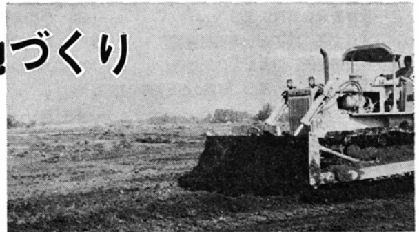
酪農団地の敷地造成工事、中据で
