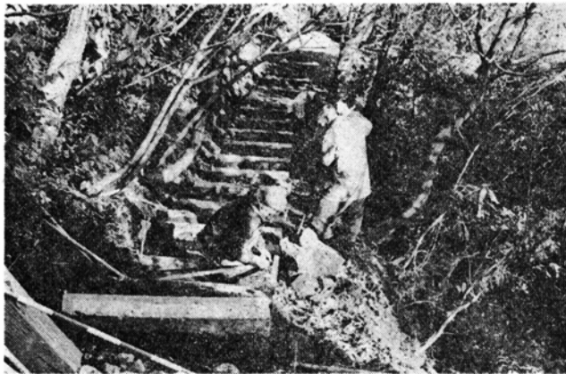
階段工事が進む百間坂
