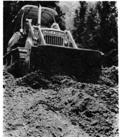
昨年から工事を進めている鬼谷林道
