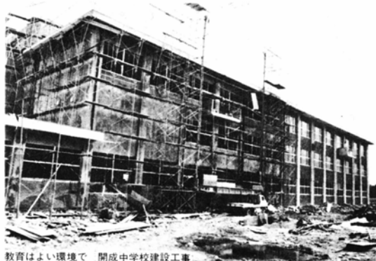
教育はよい環境で 開成中学校建設工事
