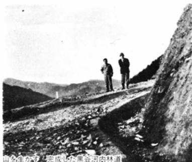
山の生かす、完成した黒谷河内林道
