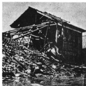
▲富田小学校の惨状（S40） ▲40・9風水害 ▲40・9風水害 ▲民家を襲う濁流柿ヶ島で（S40）
