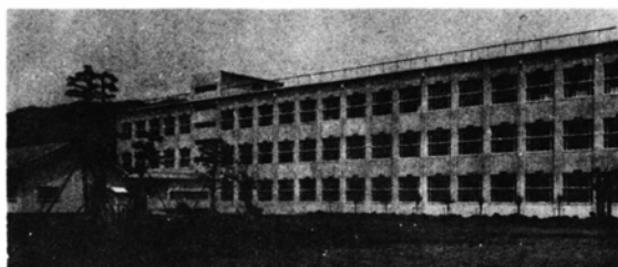
▲初めての鉄筋校舎下庄小学校校舎完成(S 32)
