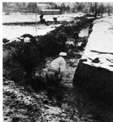
4号用水のしゅんせつ工事
