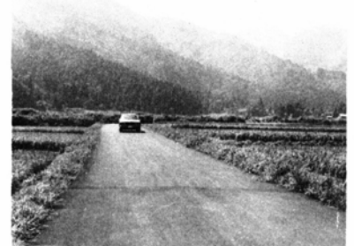
舗装が完成した下黒谷上黒谷線
