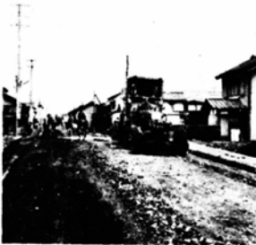
昭和42年 七間線の舗装工事
