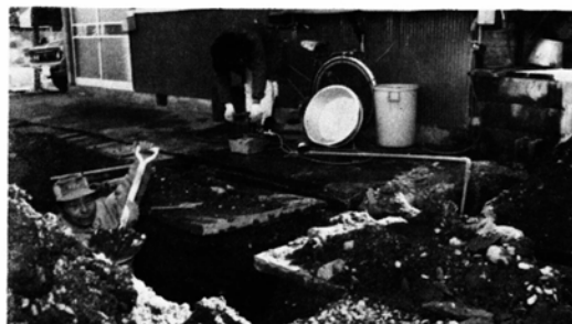
各戸への給水工事（春日一丁目で）
