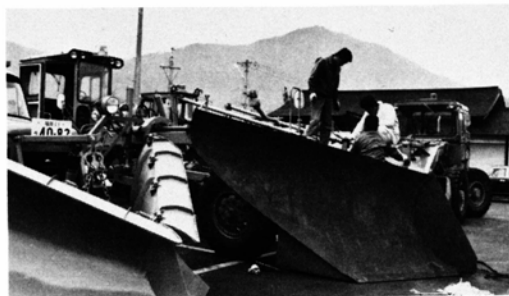
除雪板を取り付ける作業員
