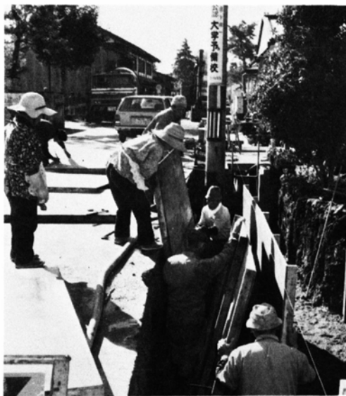
延1,890mの流雪溝工事（城町で）
