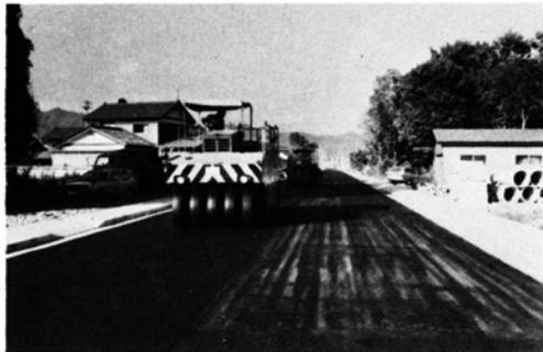
仕上げ作業が進む三番線
