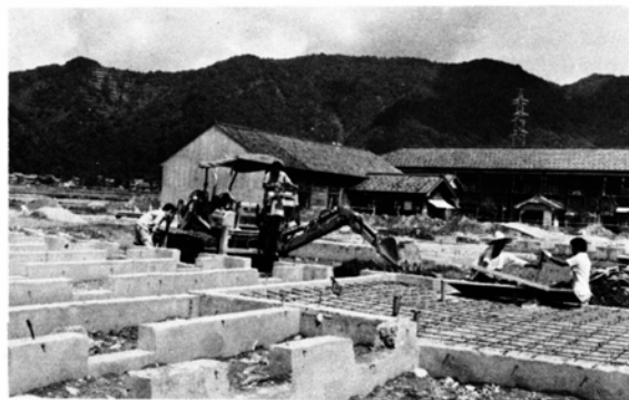
基礎コンクリート打ちを終えた乾側小建設工事
