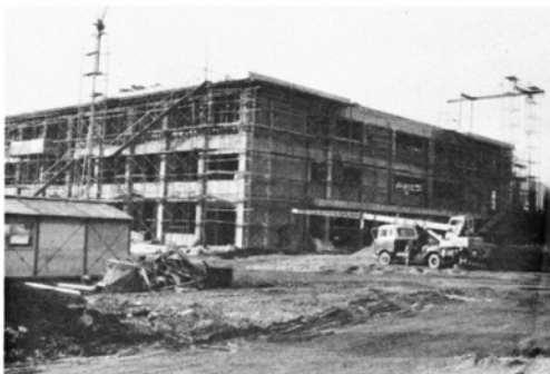
順調に工事が進む有終南小校舎
