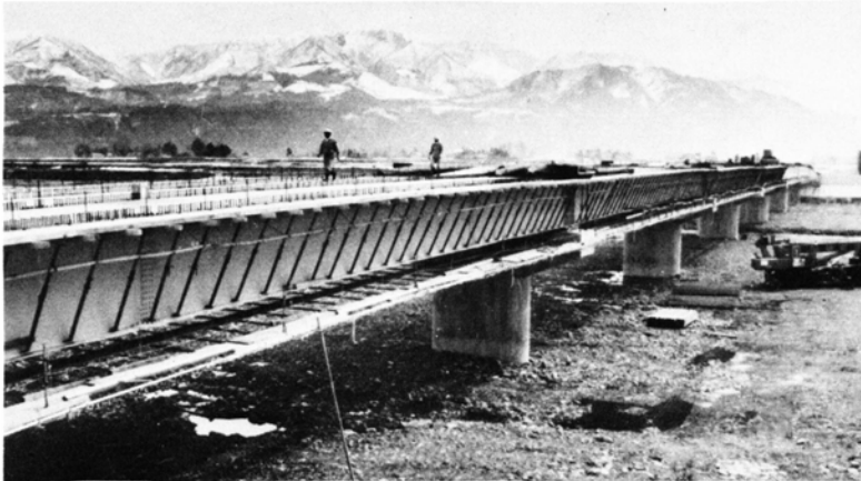
新在家～下麻生島を結ぶ広域農道の真名川新橋
