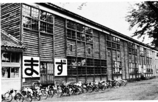
昭和13年に建設した現在の校舎
