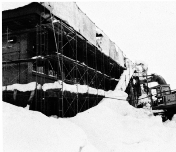
雪の中、工事が進む勤労青少年ホーム
