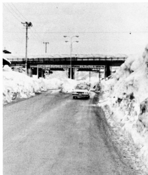
拡幅と仮舗装工事が終わった 三番線（中野地係）
