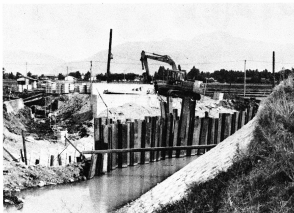
架け替え工事が進む上荒井橋
