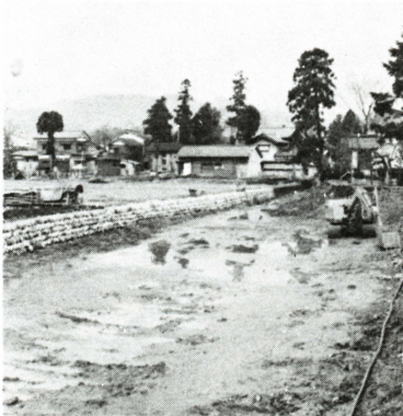
改修された石垣
