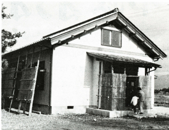
完成した西据集落生活改善センター
