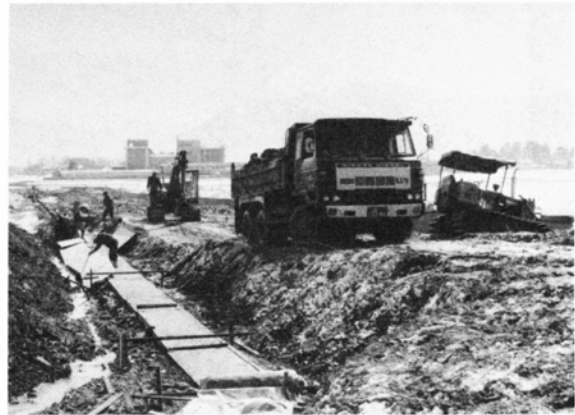
道路開設が進む鎌掛・新庄・東中線
