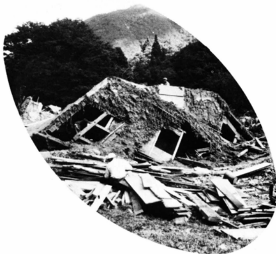
北美濃地震で倒壊した家屋 (36年8月)
