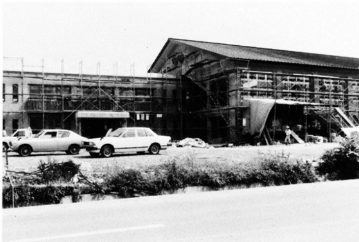
コンクリート打ちが終わったセンター
