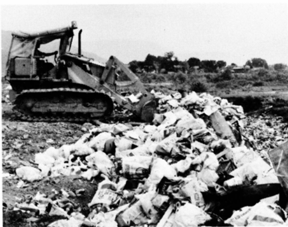
不燃物の埋め立て地
