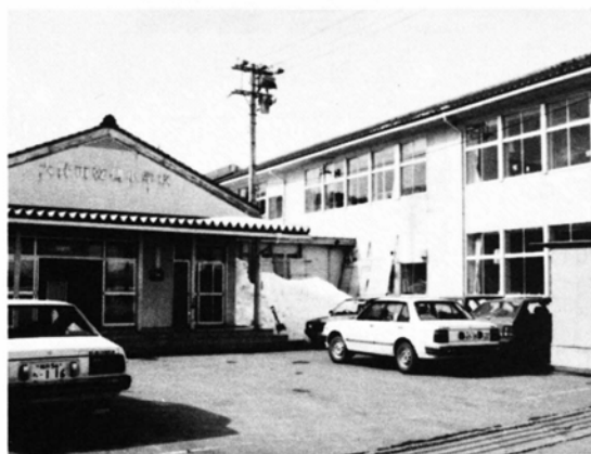
乾側小の校舎
