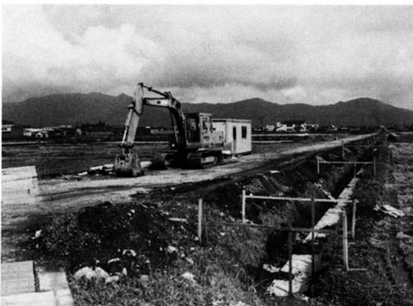
本年度は側溝や用・排水路の整備が主体
