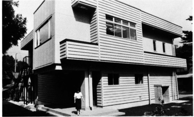
木本分校跡地に完成したセンター
