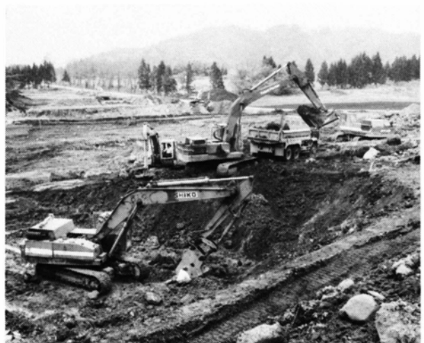
造成工事が始まった野外活動施設
