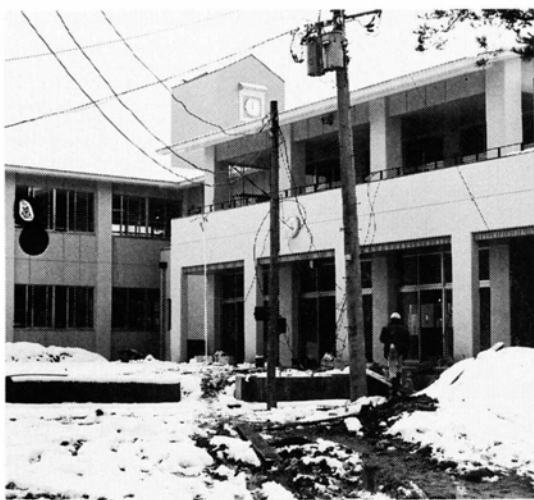
完成間近の上庄中学校舎
