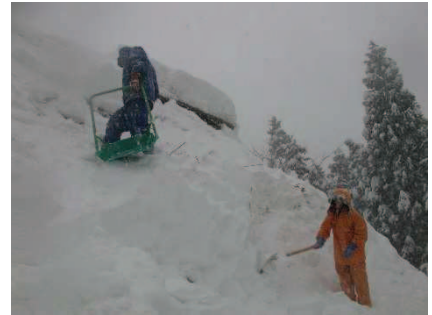
写真1 旧橋本家住宅の雪下ろしの様子
