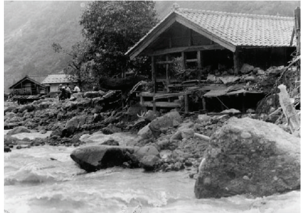
写真 24 台風 23 号による風水害（西谷地区）
