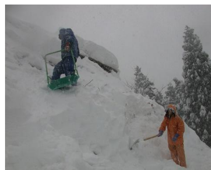
写真1 旧橋本家住宅の雪下ろしの様子
