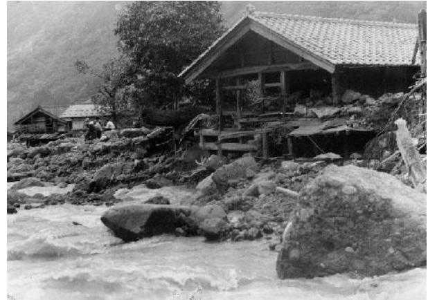
写真 24 台風 23 号による風水害(西谷地区)
