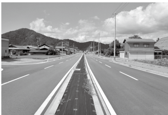
国道157号大野バイパス整備
