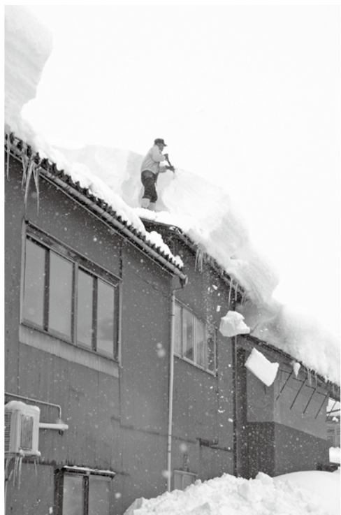
屋根雪下ろし作業の様子
