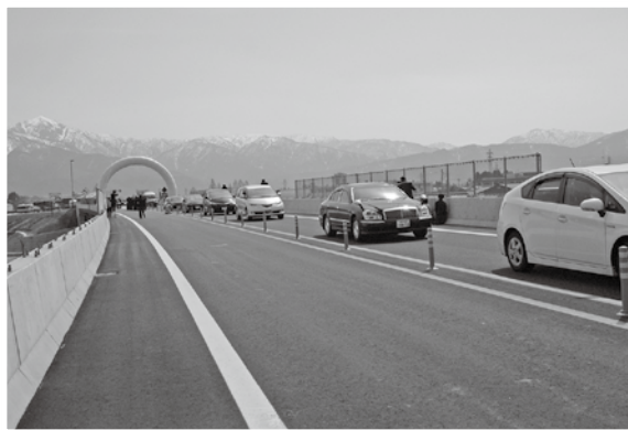
中部縦貫自動車道
