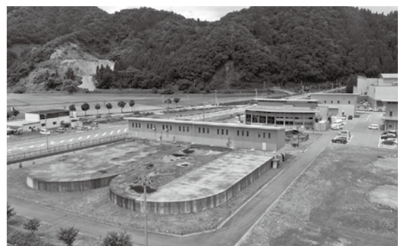
大野市下水処理センター
