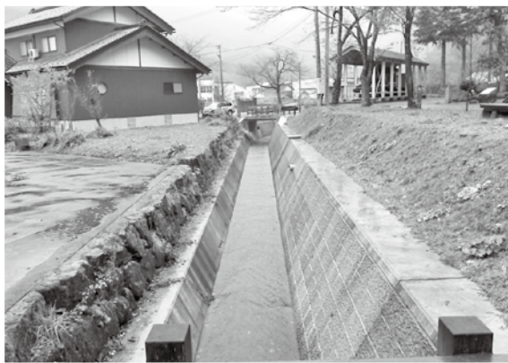
河川改修工事
