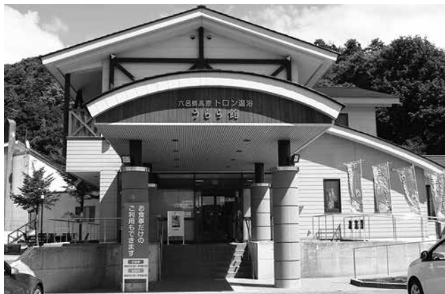
六呂師高原トロン温浴施設うらら館
