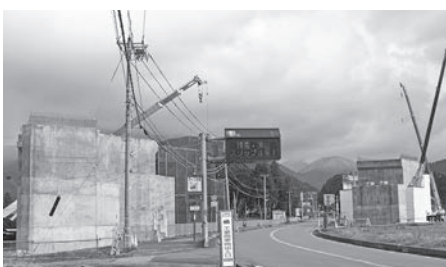
国道158号を横断する中部縦貫道の橋台工事（大野東IC付近）
