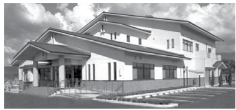
大野市浄化センター
