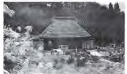
完成間近い橋本家
