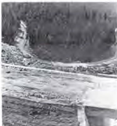
完成間近い鬼谷林道
