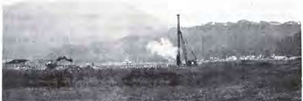
ようやく着工された開成中学校工事
