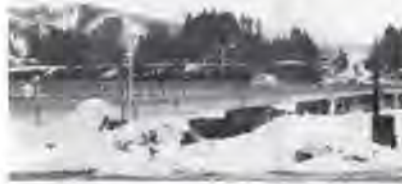
またれる阪谷橋の早期改修
