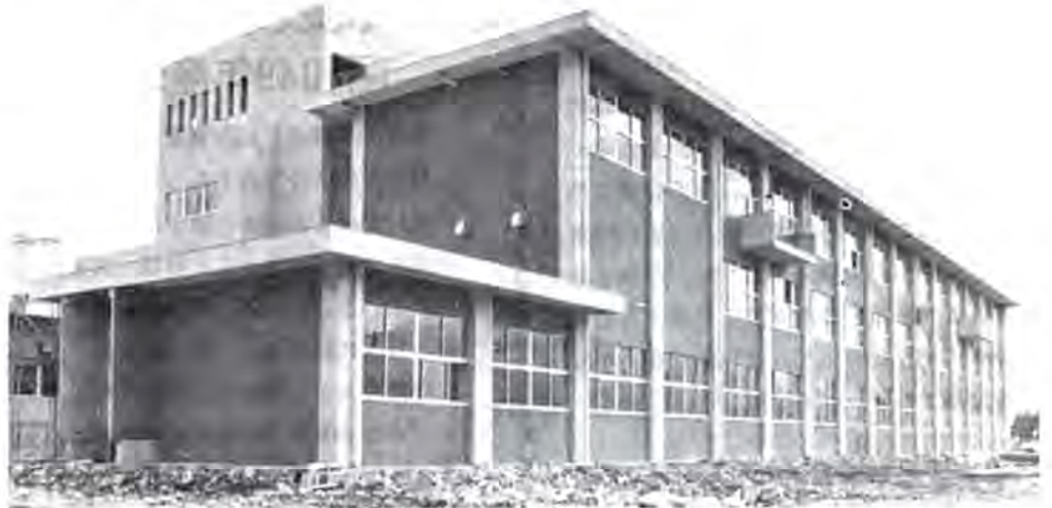
普通教室を中心に完成した開成中学校第一期工事
