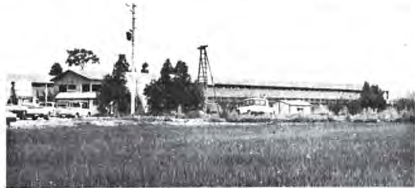
問題になった養鶏団地建設現場(吉村地区)
