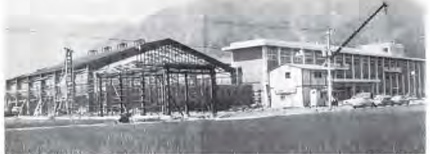
開成中学校屋内体育館工事着工 (12月上旬に完成予定)
