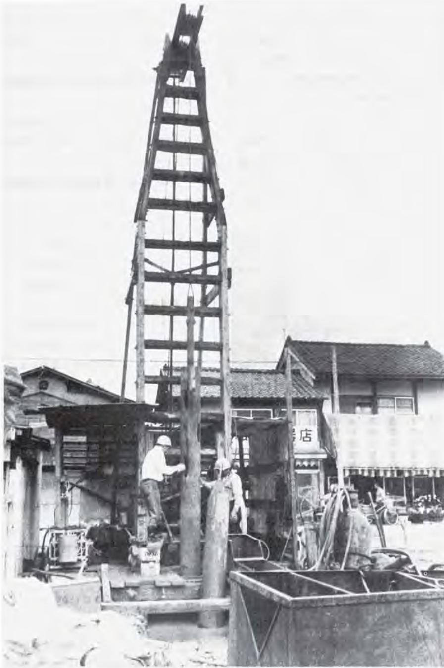
日吉町で観測井掘削(地下水の動向精査)
