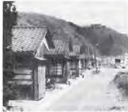
老朽化した市営住宅(新在家)
