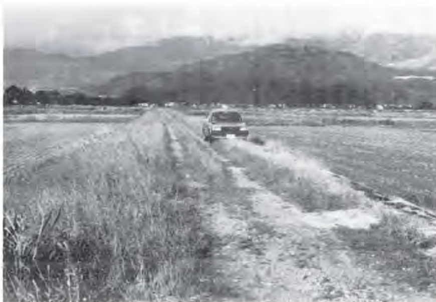
路面の舗装が望まれる農道
