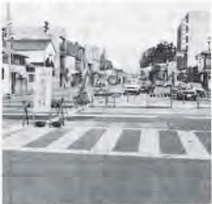
融雪工事が進む六間通り
