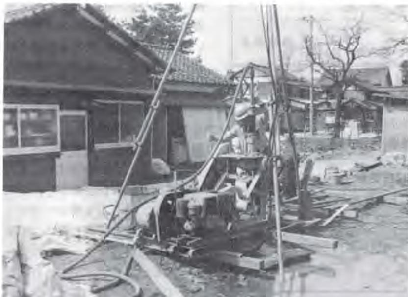
井戸枯れによる鉄管の打ち込み作業
