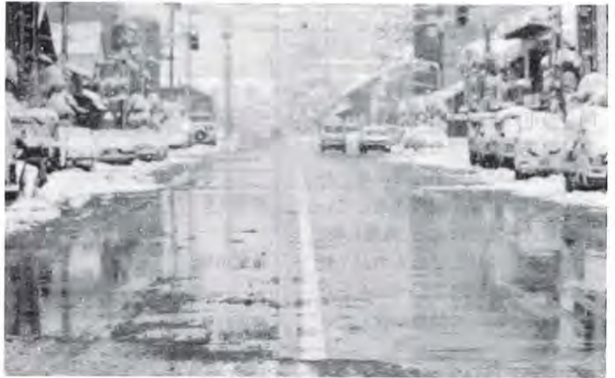
地下水利用による道路融雪
