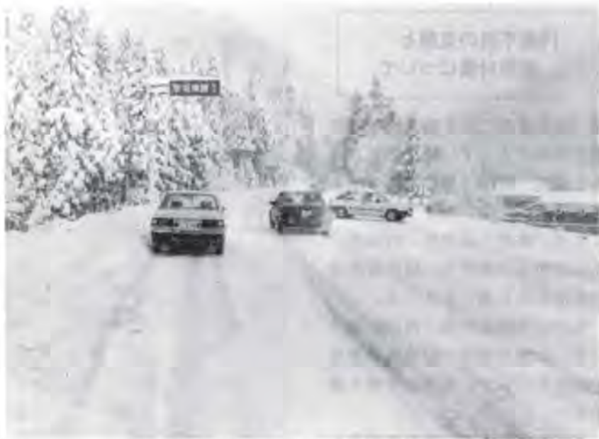
早期整備が望まれる国道158号線(花山峠)
