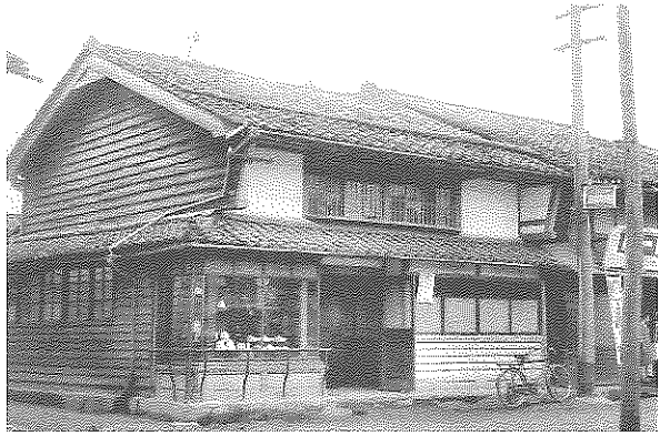
京都電燈会社大野支社（昭和初めごろ） （『大野紹介寫眞帖』より）
