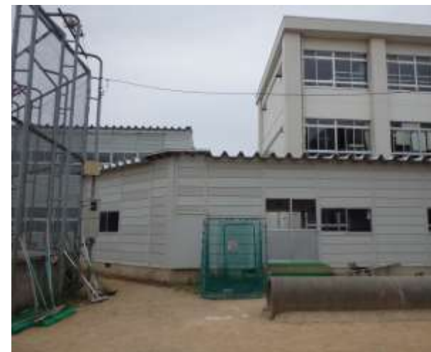
【渡り廊下外観】
