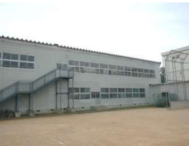
【校舎外観(外壁:パネル)】
