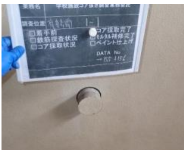
【コアの抜き取り状況】
